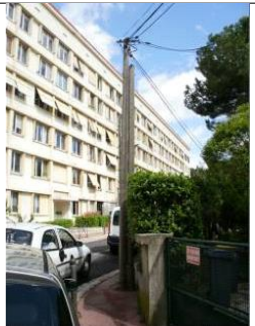
Appui moisé (ou jumelé) en angle
