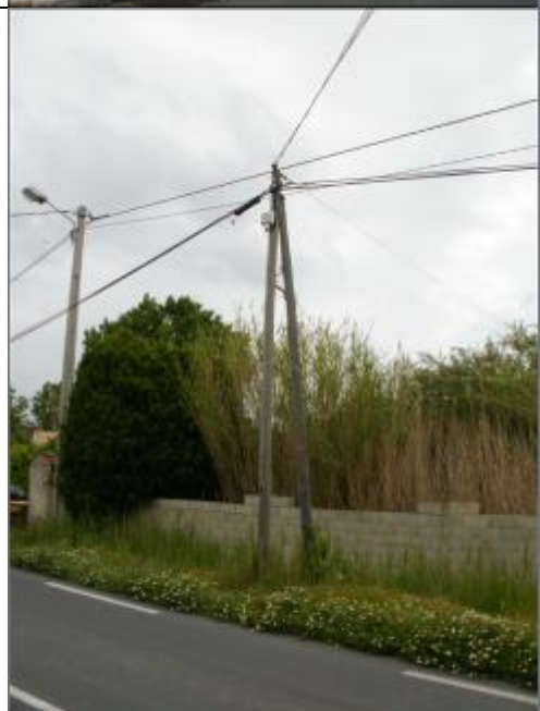
Appui couple (ou contrefiché) en angle
