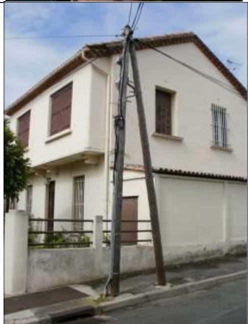
Appui couple (ou contrefiché) en arrêt
